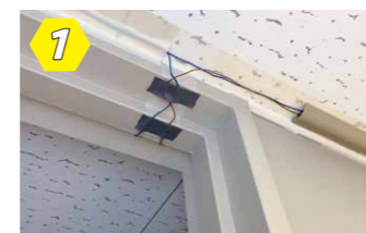
① シャワールームの扉にしっかり取り付けられたスイッチ部。
