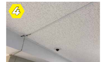
④ 修繕後は強度が増し、落下の心配がなくなった。
