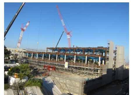
建設中の中央棟(撮影：2019年9月)
